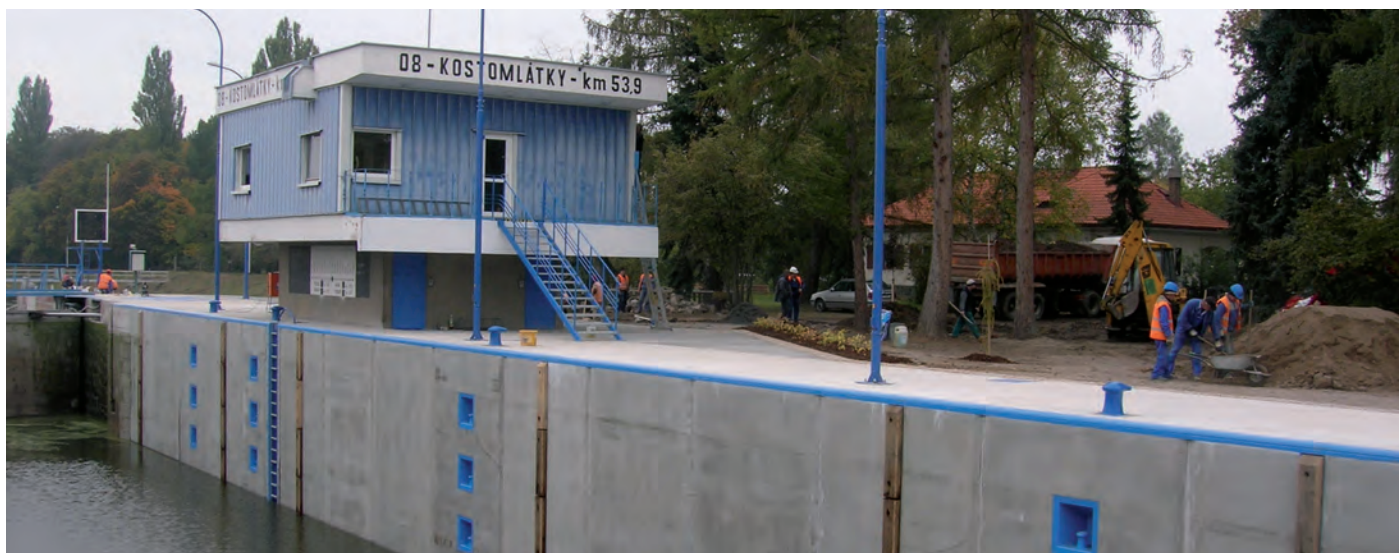
VD Kostomlátky – rekonstrukce zdí plavební komory
